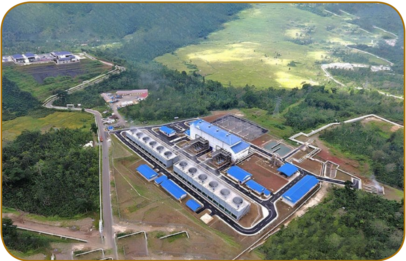
Pertamina Geothermal Energy Ulubelu (foto/ www.pge.pertamina.com )
